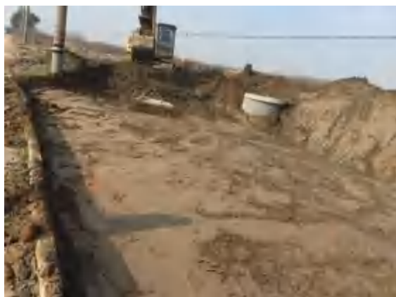
路基清表施工
