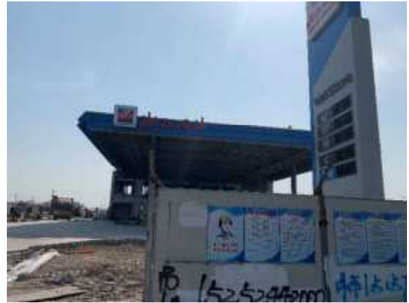
5 标项目部拆除平整后已建设为加油站
