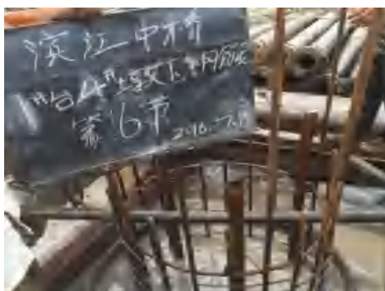
桥梁桩基施工
