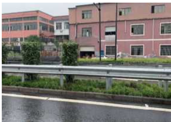
K6+000 处中央分隔带绿化现状
