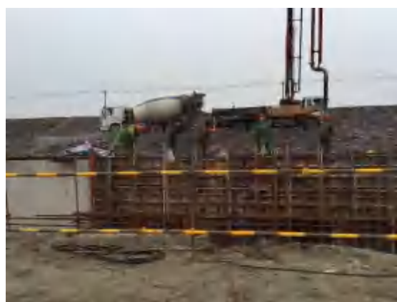
箱涵工程施工
