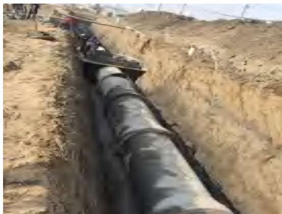
道路雨水管施工
