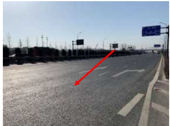
2 标原拌合站位置（红线内，已建设为路基）
