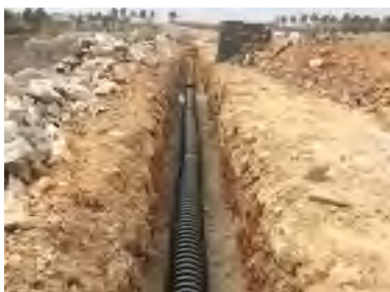
雨水管道施工
