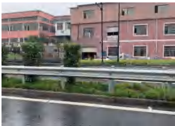
K6+000 处中央分隔带绿化状况
