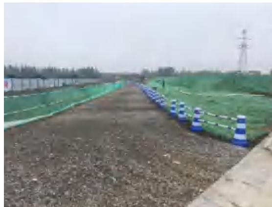
裸露面临时覆盖 2
