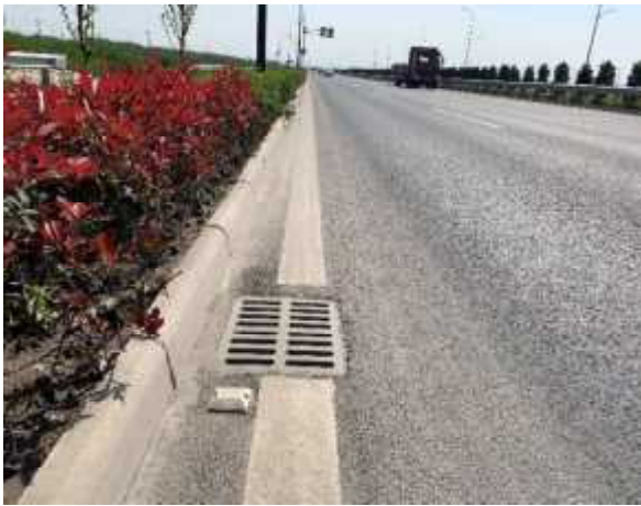
主线 K28+900 处道路雨水口及绿化
