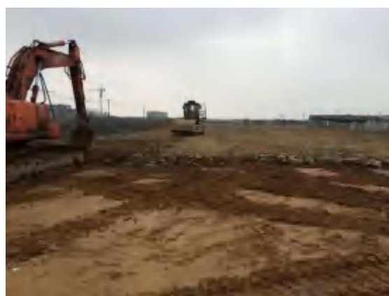
路基填筑施工（7标，2017年）
