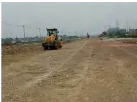
路基填筑施工
