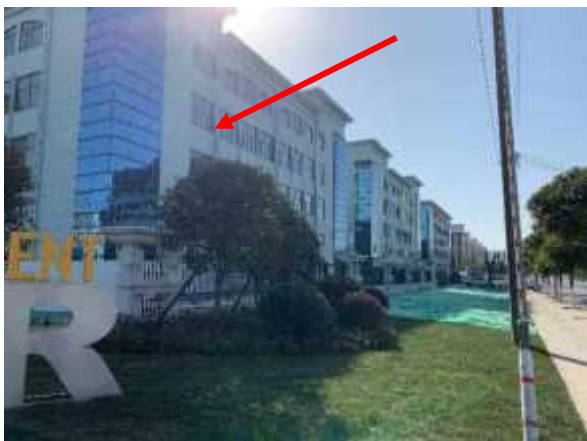
原 3 标拌合站位置，现已建设为数智港
