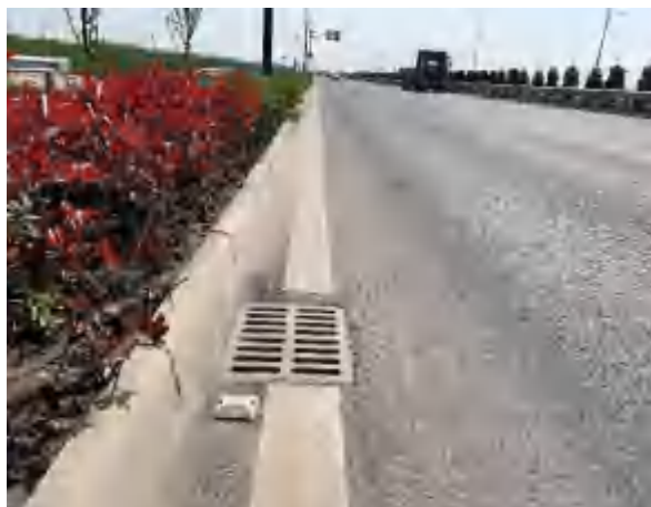
主线 K28+900 处道路雨水口及绿化
