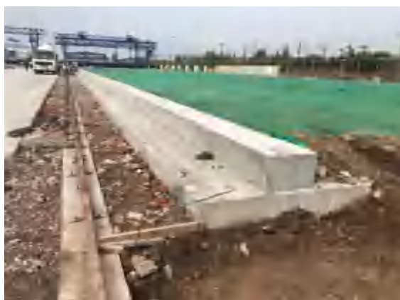
裸露面临时覆盖 1
