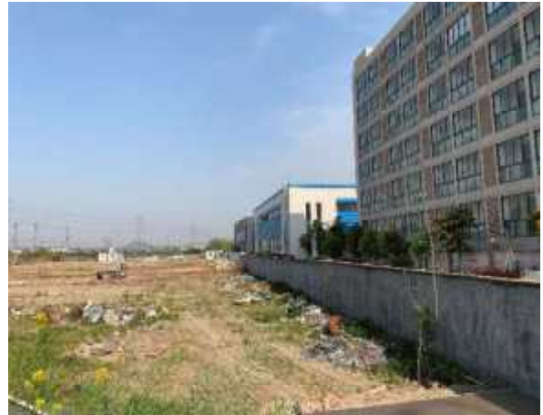
主线起点处搅拌站利用完毕后场地平整
