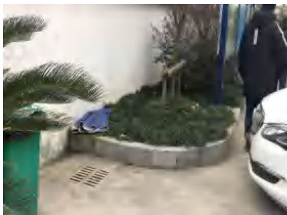
施工场地内临时绿化、排水
