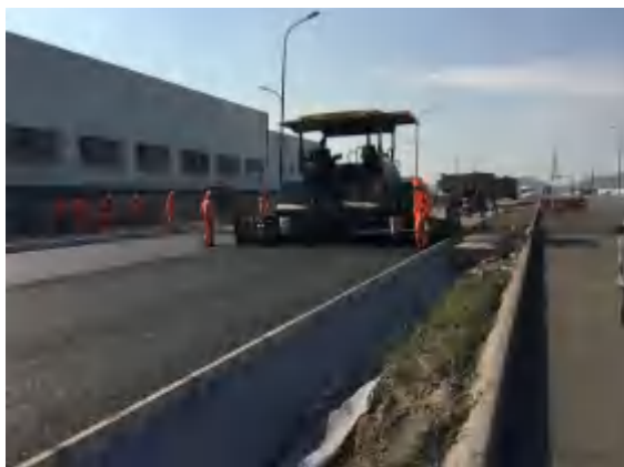
道路路面、雨水管施工
